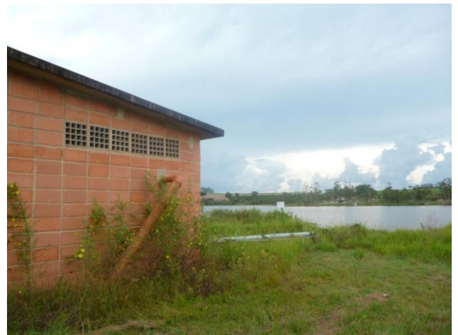
Foto 4.3 - Casa de Bomba – Captação Represa
