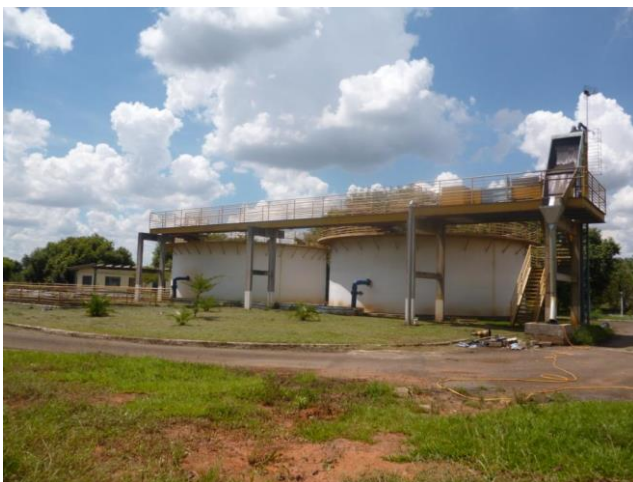
Foto 4.17 - Vista Geral da ETE
