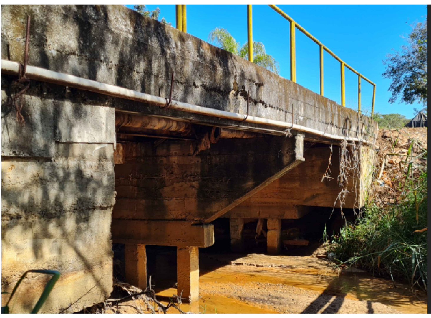
VISTA LATERAL DA PONTE ONDE SERA FEITA A FIXAÇÃO DA TRAVESSIA
