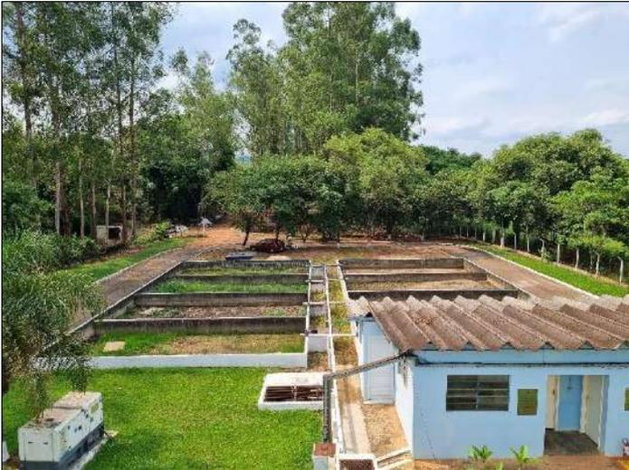
Foto 21: Estação de tratamento de esgoto - ETE do Distrito Sede – destaque para os leitos de secagem de lodo (25/10/2023).
